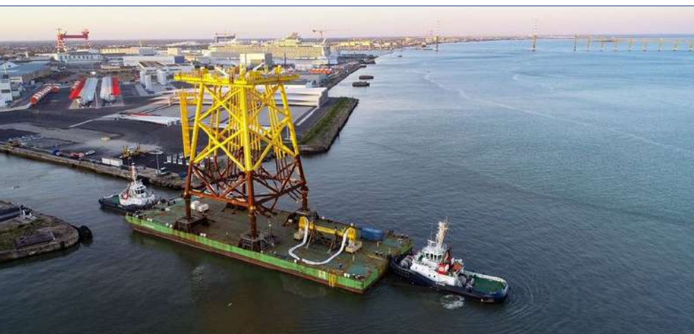
Figure 8 : Le transport de la fondation jacker de la sous-station du parc de Saint-Nazaire.
