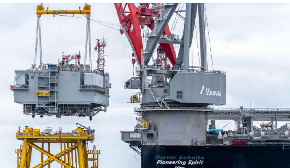
Figure 9 : L'Installation de la sous-station électrique en mer.
