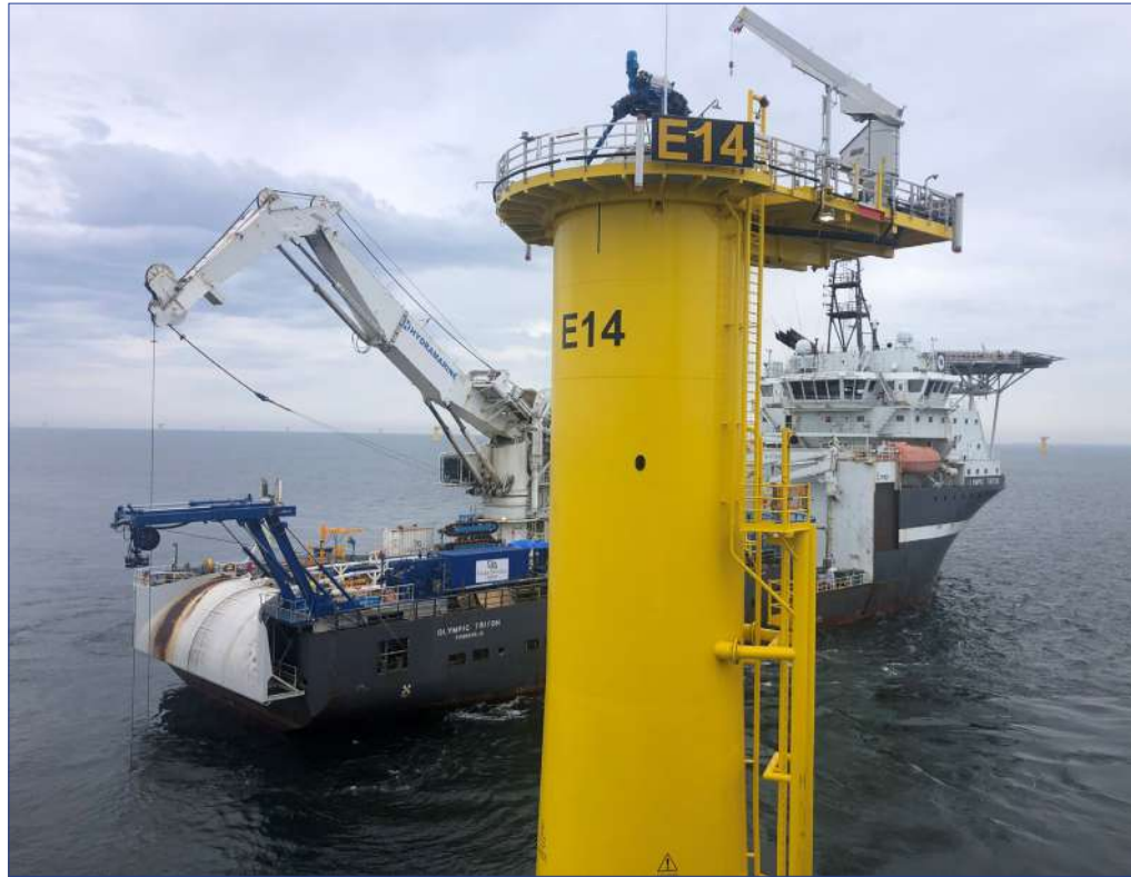
Figure 10 : L'installation des câbles inter-éoliennes.
