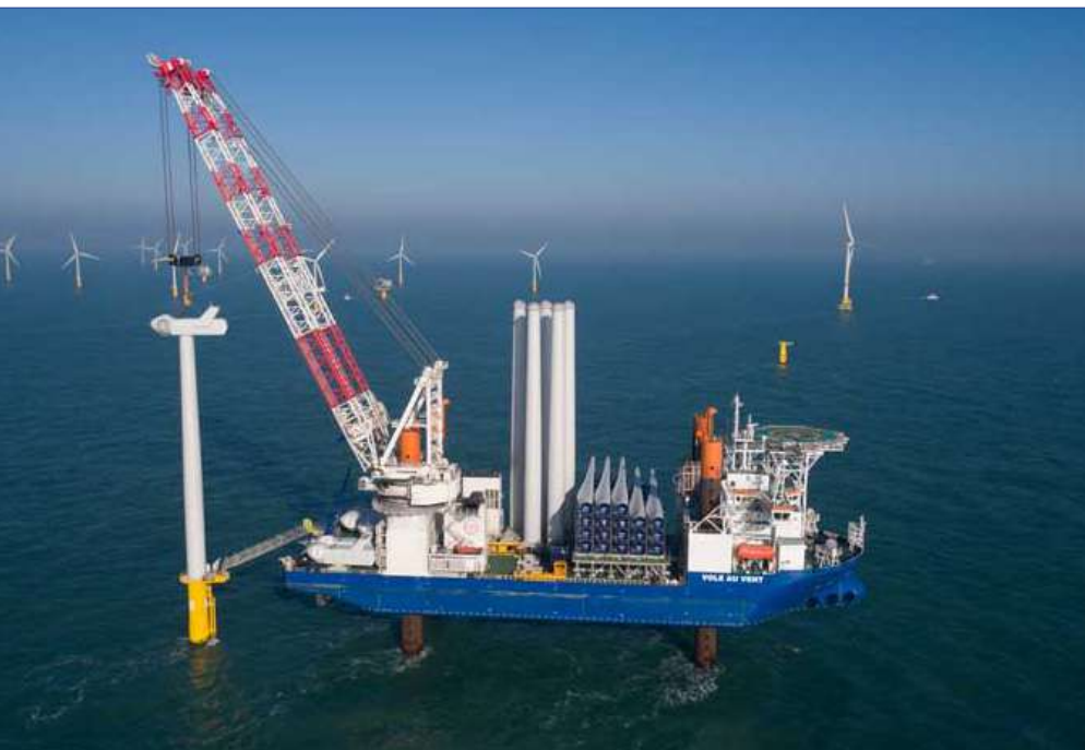
Figure 11 : Le transport et l'installation des éoliennes du parc de Saint-Nazaire par le navire auto-élévateur.
